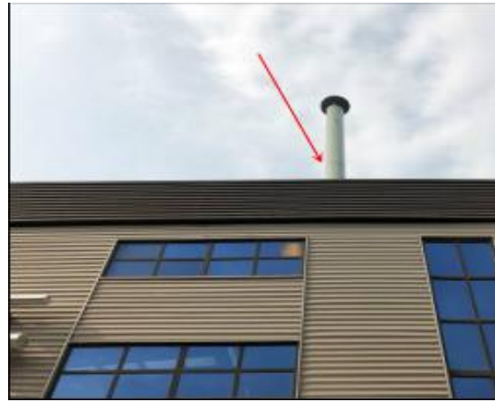
达克罗生产车间 15m 高排气筒
